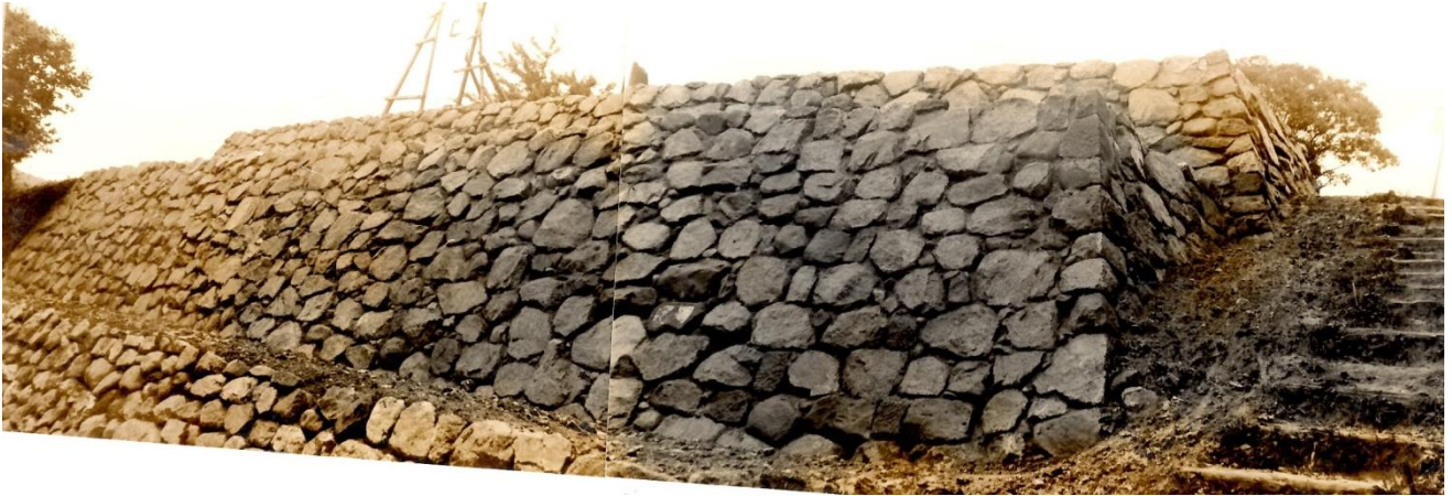
写真 19 A0102・101 全景 (S42 復旧後)
