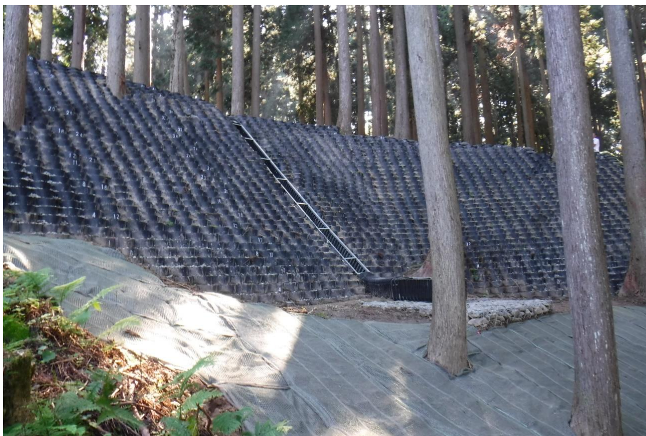
6. 部分写真（東から、完了後）
