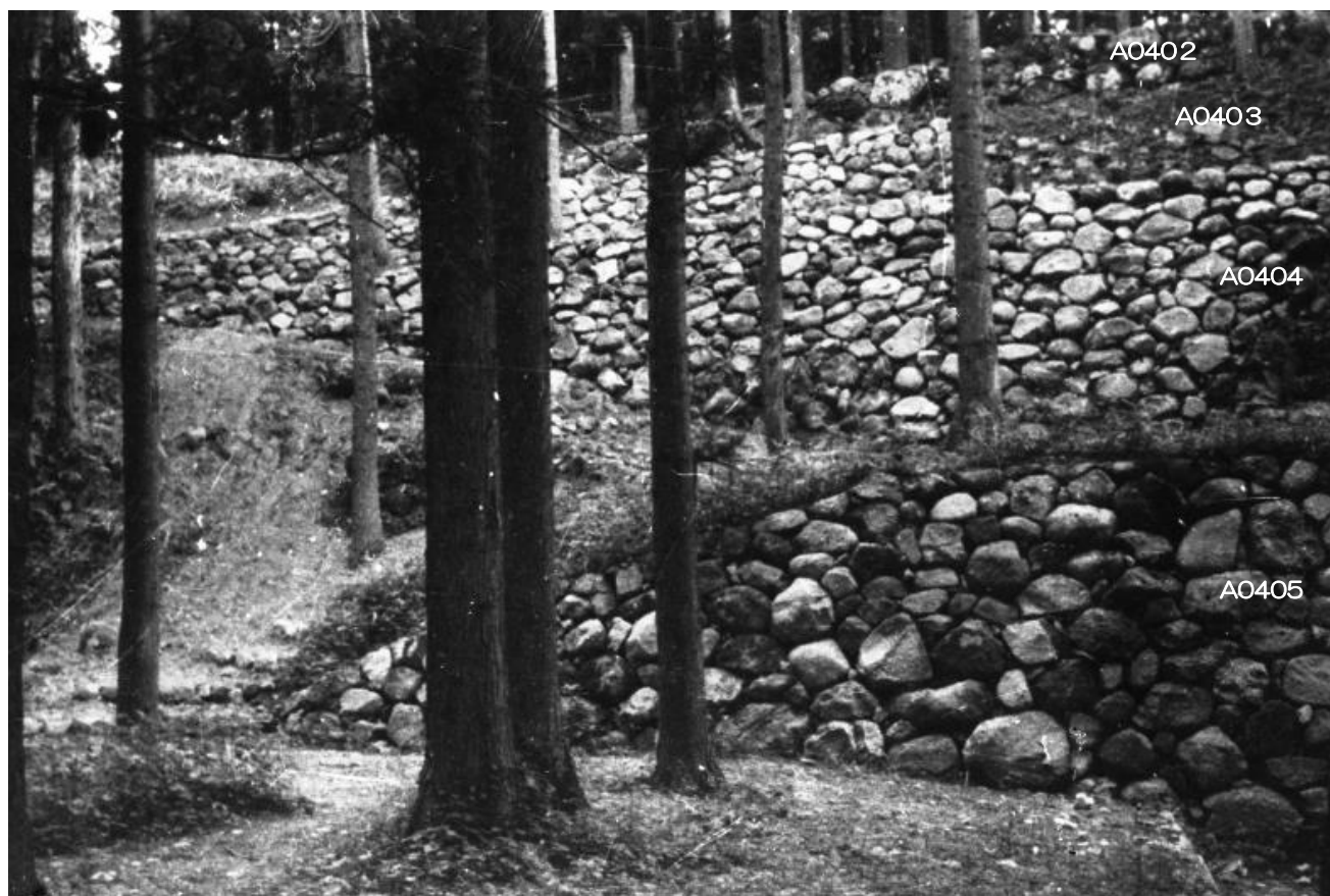
写真11 桜馬場北側石垣(A0402～404、昭和33年復旧後)
