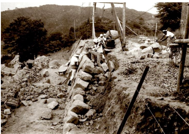
写真 17 A0101 復旧状況(S42)
