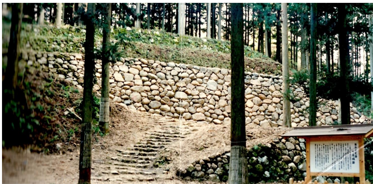
写真 25 A0404全景（H元 復旧後）
