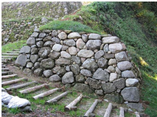
写真 30 A0104 - 2 (復旧後,北面)
