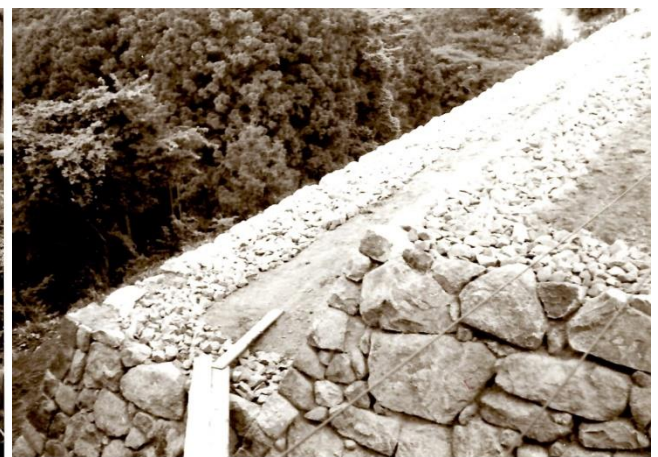
写真 18 A0101・102 復旧後
