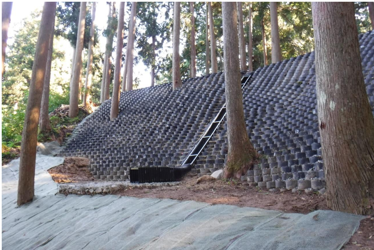
5. 部分写真（西から、完了後）
