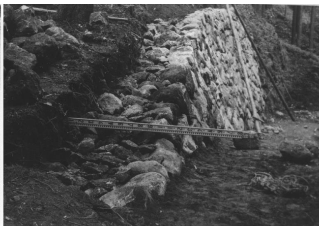
写真10 A0404(昭和33年復旧中)
