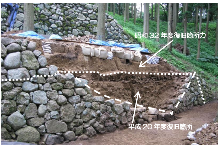
写真 1 A0405 落石除去 (H20 北東から)
