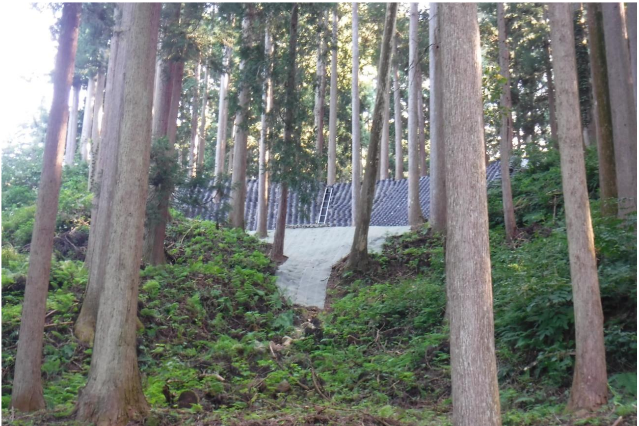
2. 全景写真（北から、完了後）
