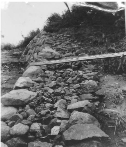
写真13 A0104(昭和34年復旧中)
