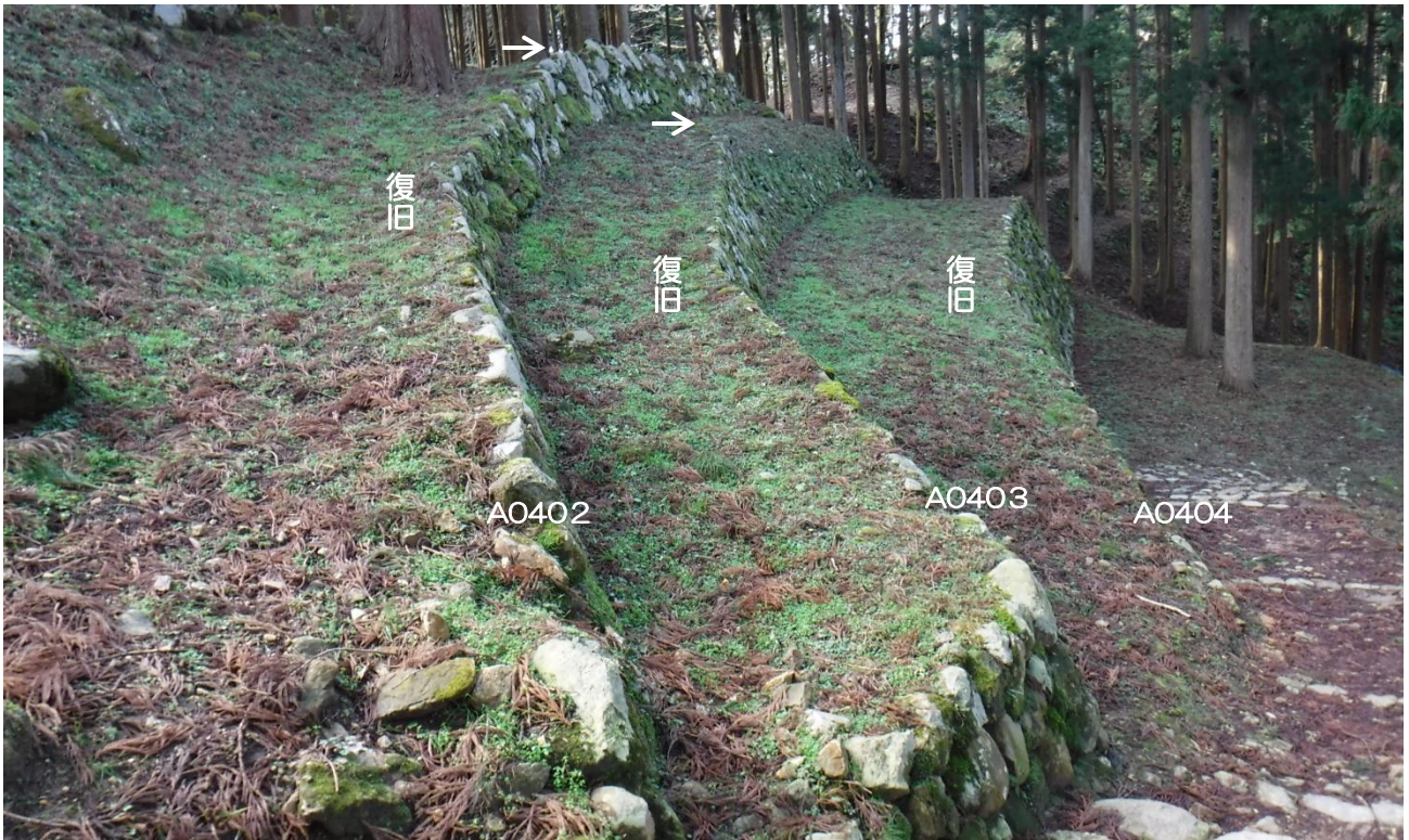
写真 12 桜馬場北側石垣現況（東から）
