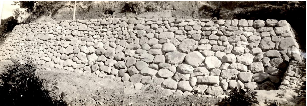
写真 16 A0103 全景 (S41 復旧後)
