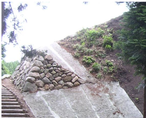
写真 31 A0104 - 2 (復旧後,西面)
