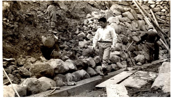
写真 15 A0103 復旧状況(S41)
