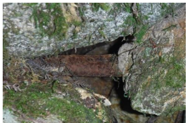
写真 4 A0811 築石内鉄棒
