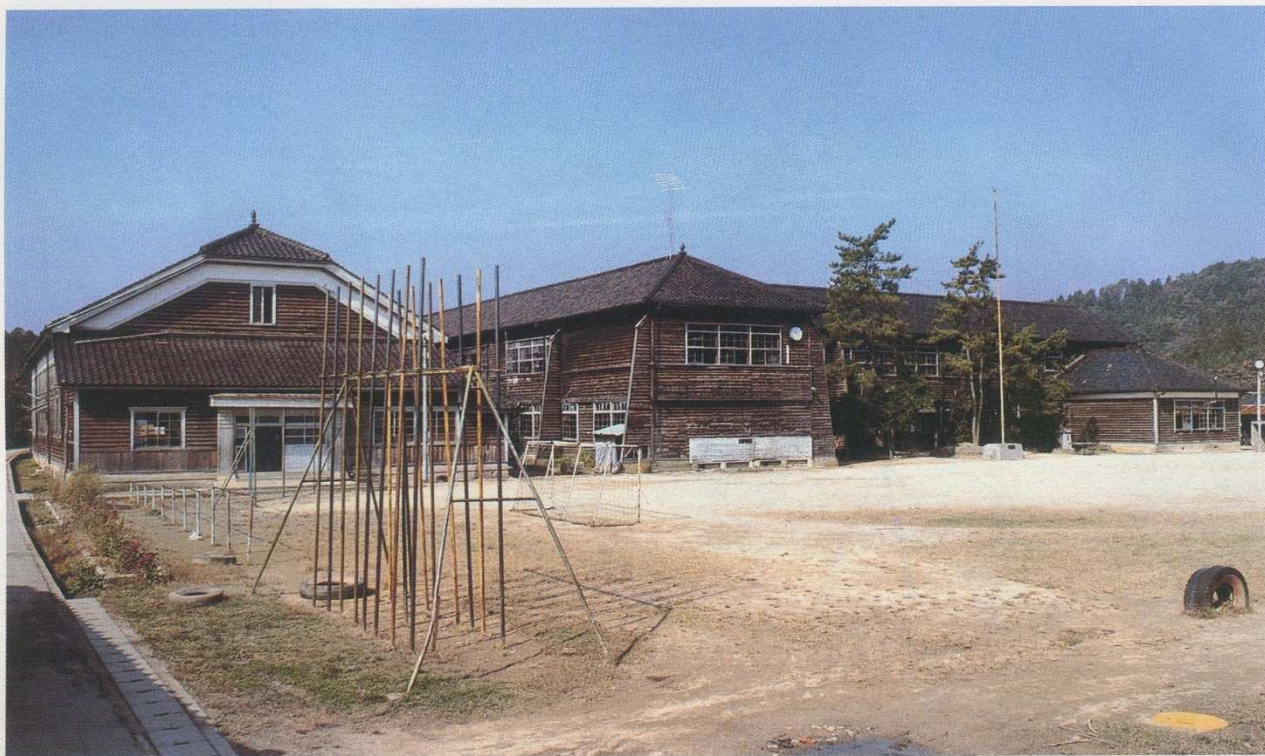
旧木造校舎（一部大正3年建築）
