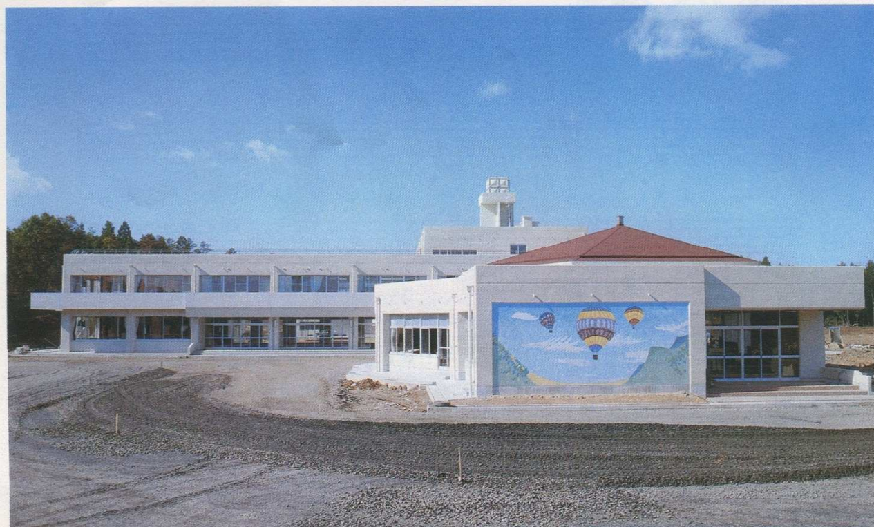
新鉄筋校舎（昭和54年11月17日完成）
