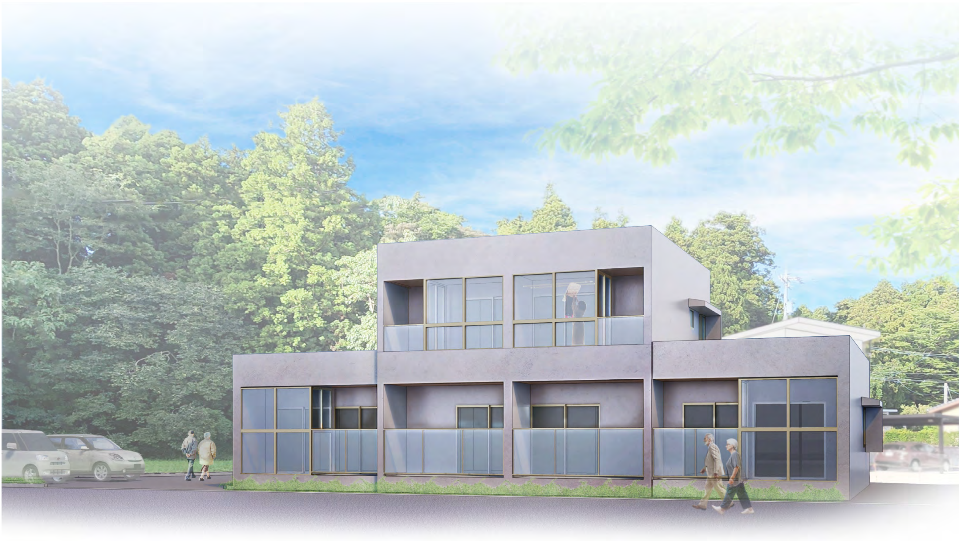
小丸山復興公営住宅（B棟）
