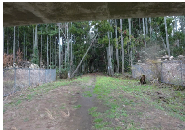
図 3-22 能越自動車道の高架下
