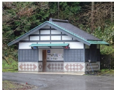
図3-26 本丸駐車場近くにある便所
