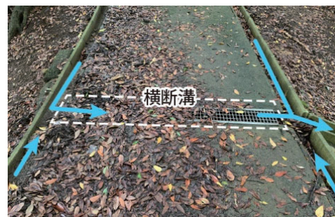
図 5-16 横断溝の整備事例
