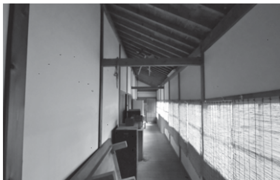
写真4-26 渡り廊下 南面
