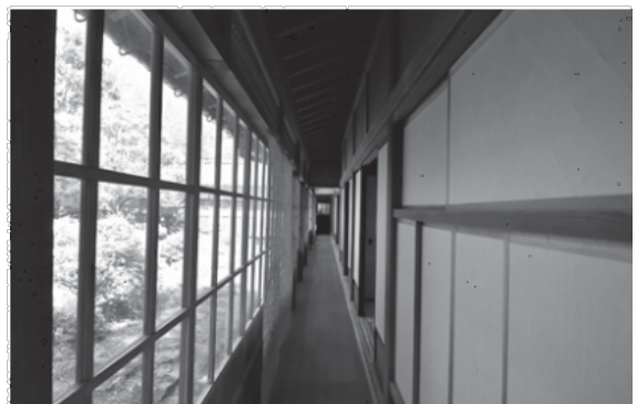
写真4-19 背面廊下 東面
