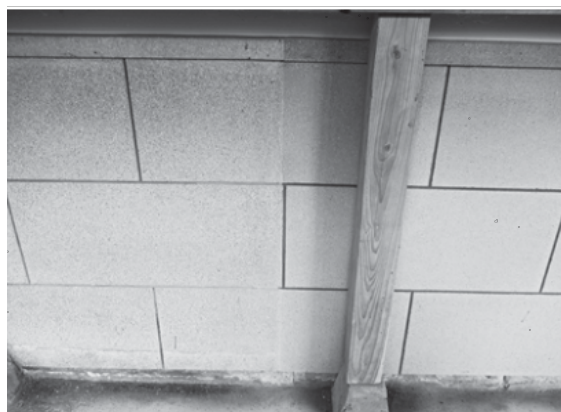
写真4-32 正面腰壁(道具蔵1・2の境)
