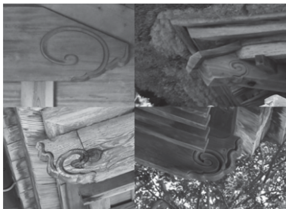
写真4-28 唐草模様の比較 (左上:道具蔵1天秤梁 右上:主屋隅木 左下:式台破風 右下:表門破風)
