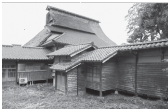
写真4-27 渡り廊下 東面
