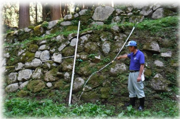
復旧石垣の現地調査の様子
