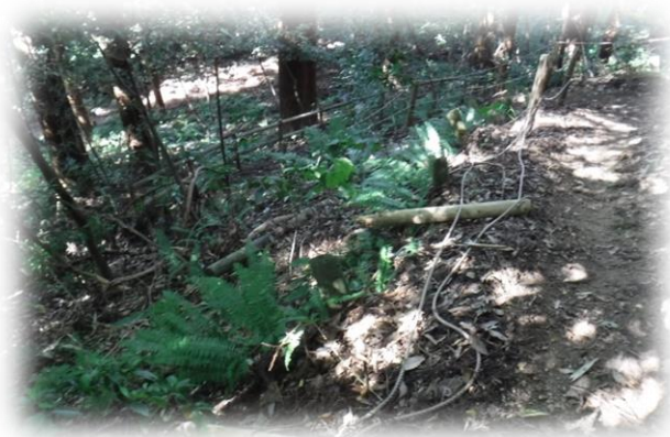
経年劣化によって倒れたロープ柵
