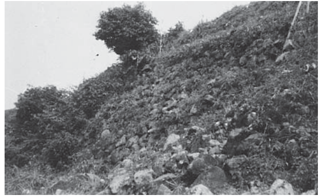
自然崩落した石垣（本丸北、昭和33年）
