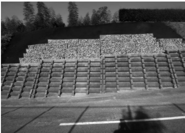
法面保護工事完了 (2号墳側)
