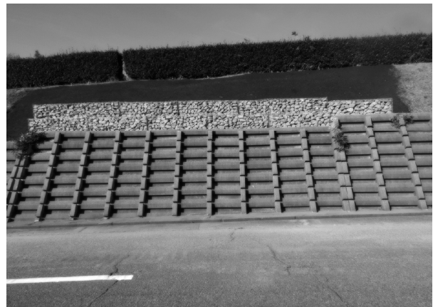
法面保護工事完了 (南側)
