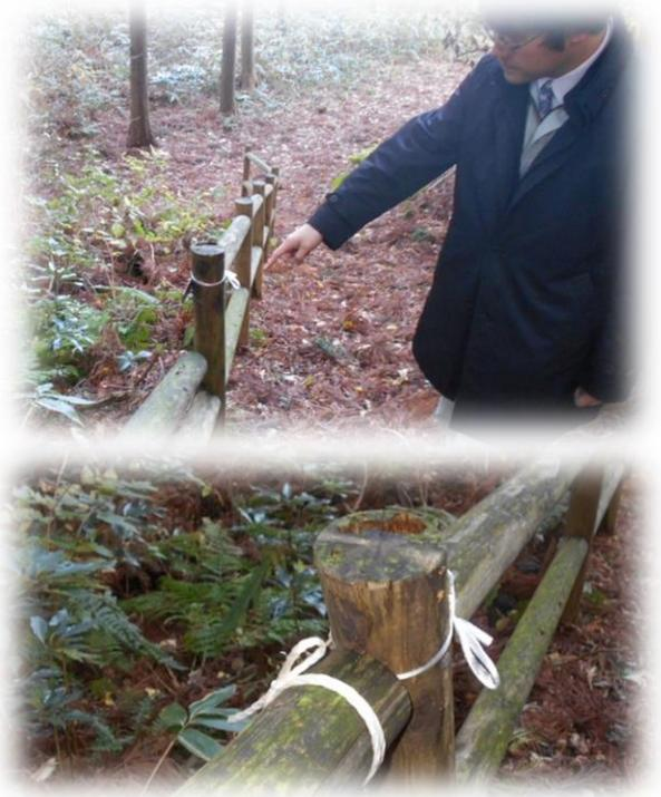
破損した手摺り（上）と補強後の手摺り（下）
