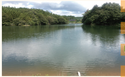
photo: 漆谷第二堤
