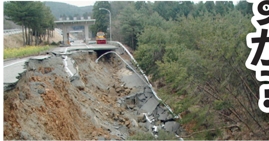
平成19年3月25日の能登半島地震で崩落した道路
