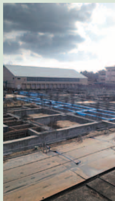
建設中の小丸山小学校
