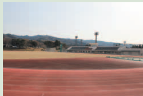
城山陸上競技場の整備
