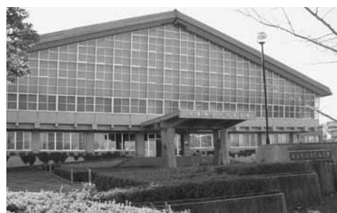
屋根が改修される七尾総合市民体育館
