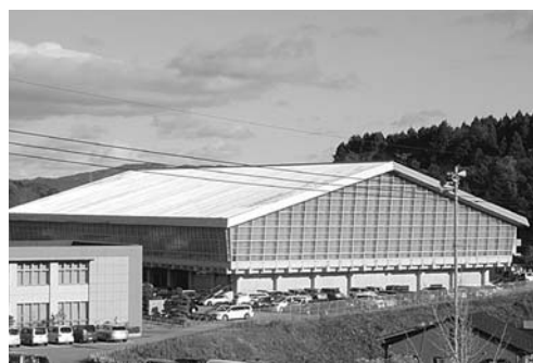
屋根が改修された七尾総合市民体育館
