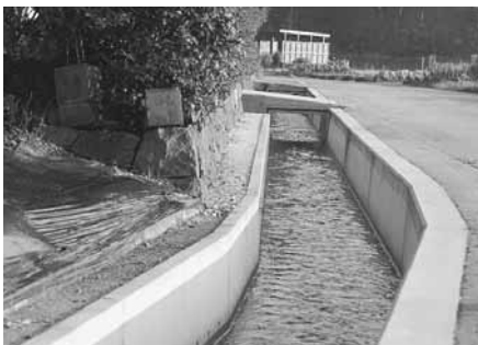
▲ 水路が整備された集落（中島町塩津地内）
