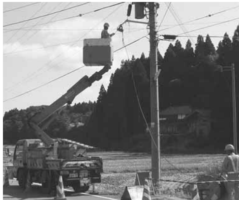
▲ 市内で順次進められるケーブルテレビ工事
