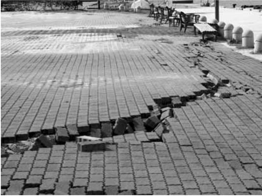
わくわくプラザ（和倉地内）の液状化現象による陥没
