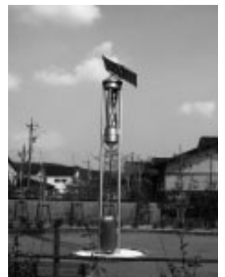
浜田コミュニティ公園防犯灯
