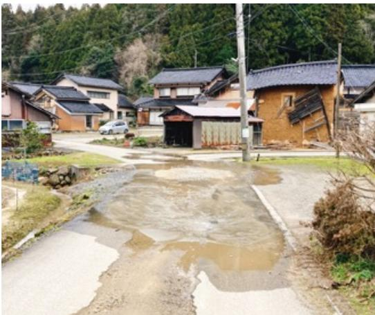
液状化 | 土砂噴射・舗装亀裂(府中町)
