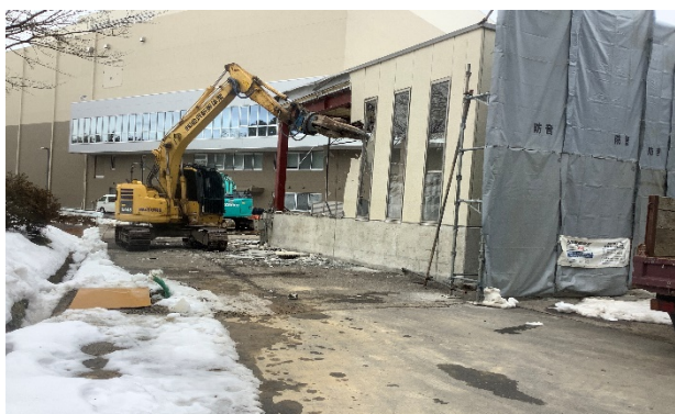
【写真①】旧計量棟建屋解体状況
