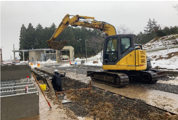
【写真①】V S側溝据え付け状況
