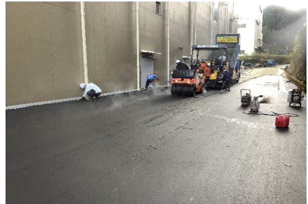
【写真②】アスファルト舗装状況
