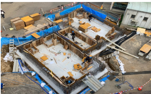
【写真①】計量棟基礎型枠組立状況
