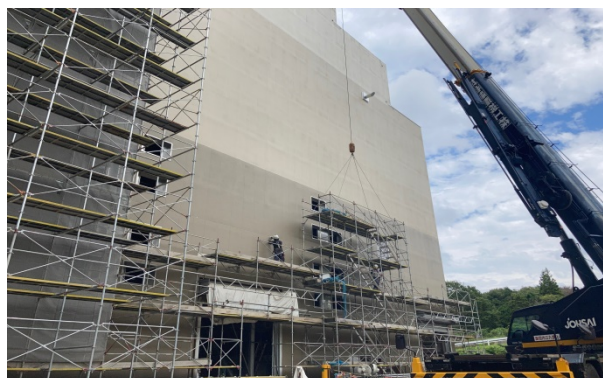
【写真②】外部足場解体状況
