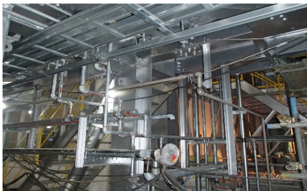
【写真③】炉室 配管工事
