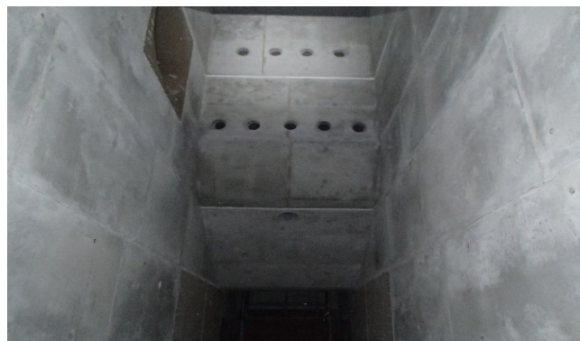
【写真④】焼却炉耐火工事
