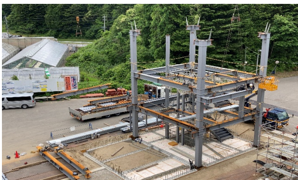
【写真①】 エントランス棟 鉄骨組立方状況
