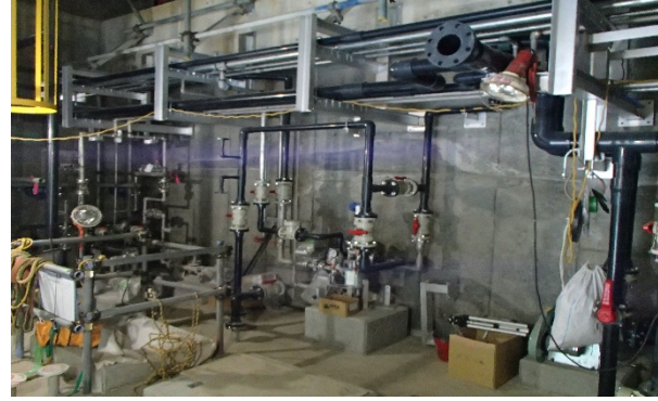
【写真④】 配管工事（排水処理室）
