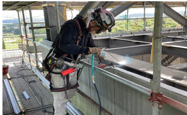
【写真②】 外壁セメント板 溶接状況
