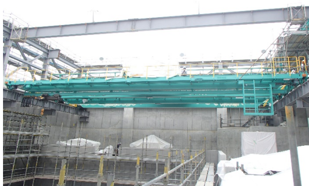
【写真③】 ごみクレーン取込み
