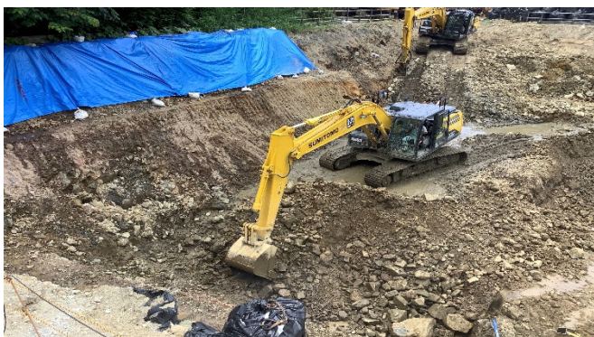
【写真①】掘削作業
