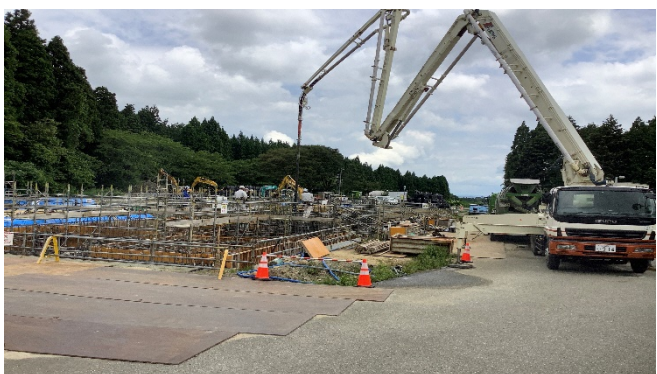
【写真③】基礎コンクリート打設
