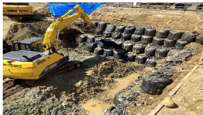
【写真②】大型土のうによる土留め作業
