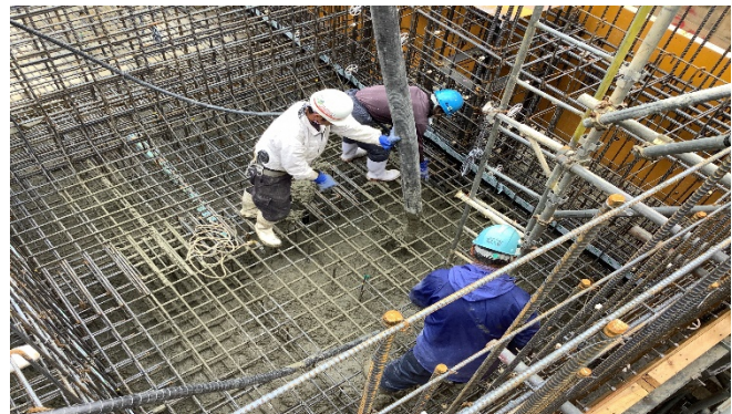
【写真④】基礎コンクリート打設
