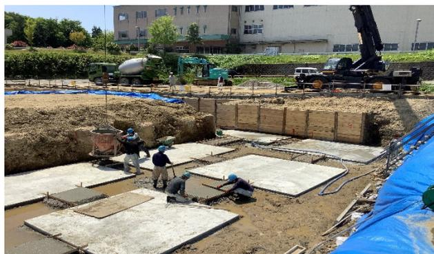
ごみピットの構造体を構築するため、重機で規定の深さまで土を掘り取り、大型土のうにより、並行して土留め作業も進めています。
