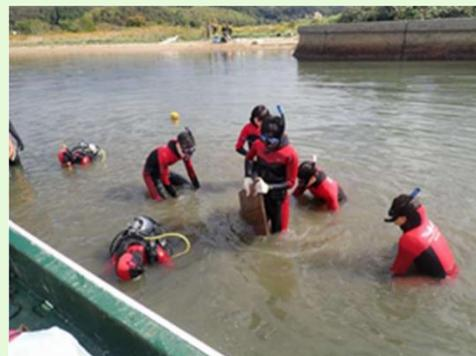
潜水部員が麻袋を鉄杭で海底に固定
