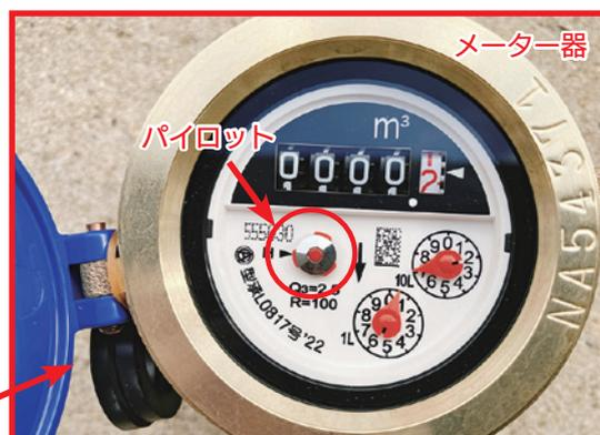
宅内の蛇口を全て閉めた状態で、メーター器のパイロットが回っているときは、漏水の可能性があります。
