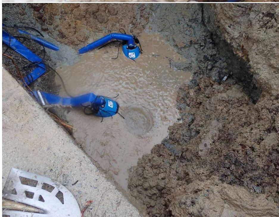
和倉駅前より市道248号沿い、漏水箇所試掘作業をしています。
