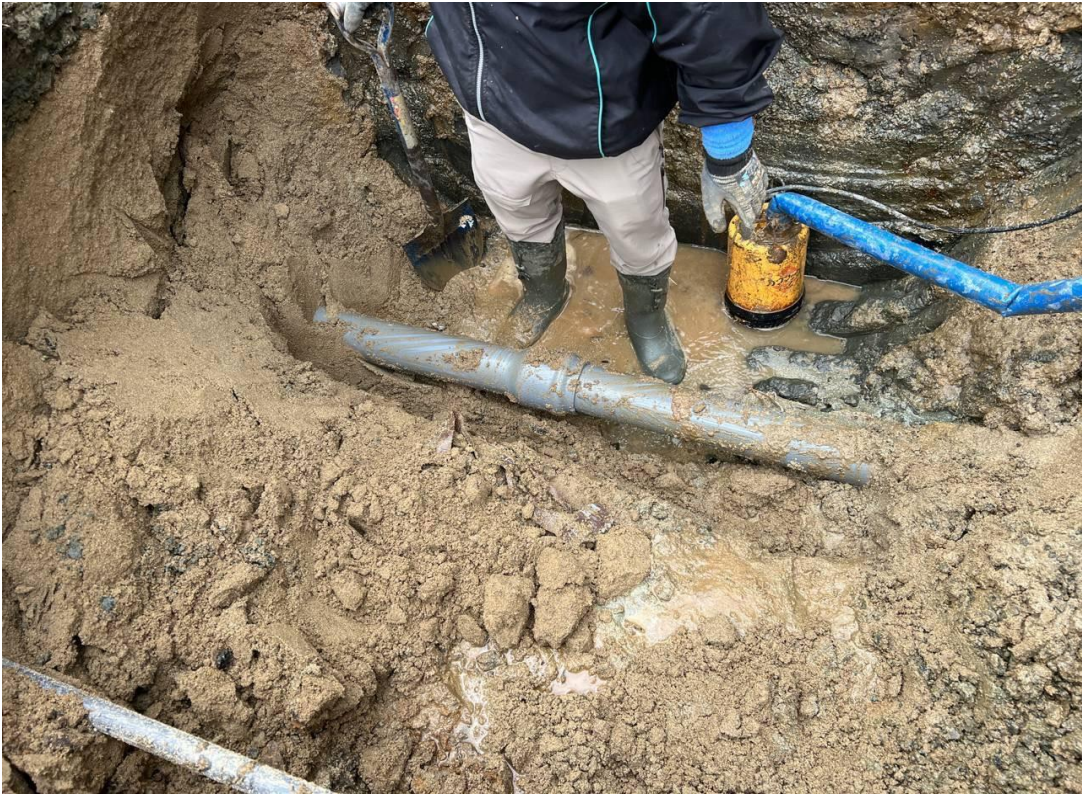
能登島二穴町地内で漏水修繕を行いました。
