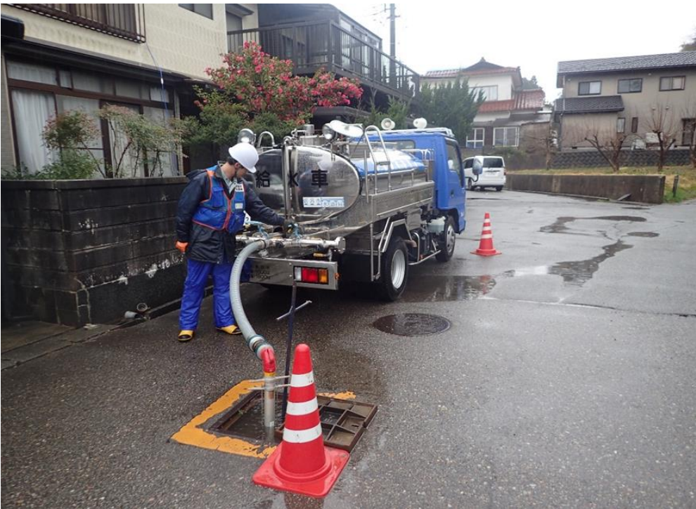
和倉町地内で給水車を利用した水道管の漏水調査を行いました （新潟市）
