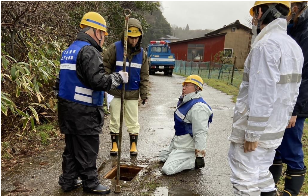
新保町地内にて、水道管空気弁の調査を行いました（名古屋市）
