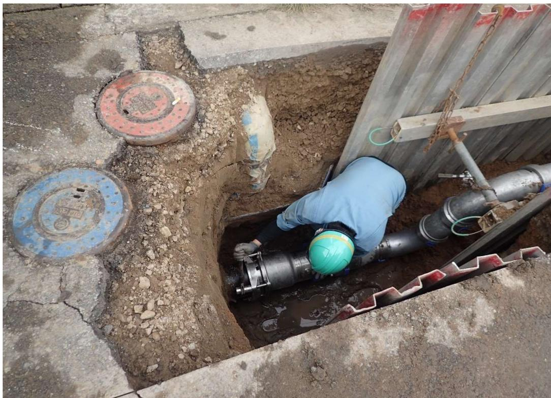
小島橋で西湊地区へ水を送るために、既設配管と仮設配管を接続しました。（新潟市）
