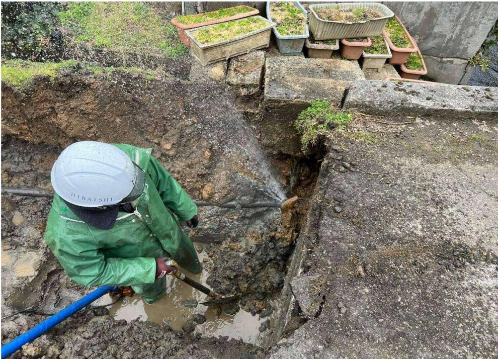
中島町外原地内で通水後に漏水箇所があったため、一時断水して修繕工事を行いました。
