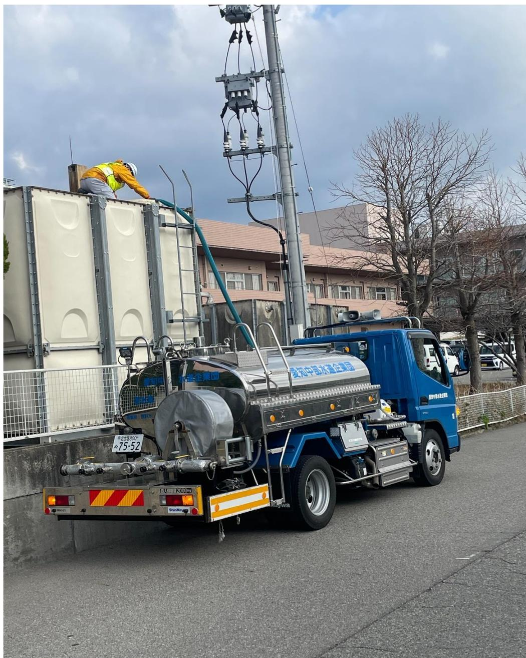
断水中の介護施設の受水槽に給水車から給水しています。
