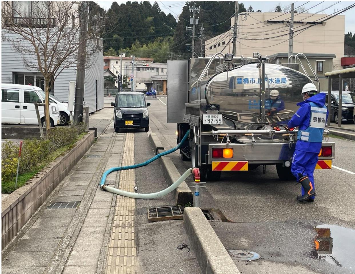
早期の復旧を図るため、和倉町地内にて給水車の水を使った漏水調査をしています。（応援自治体）
