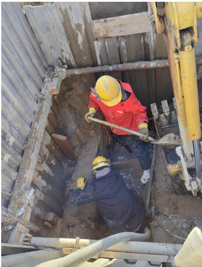
赤浦水管橋に布設した仮配管と既存の配水管を接続する準備をしています。（名古屋市）
