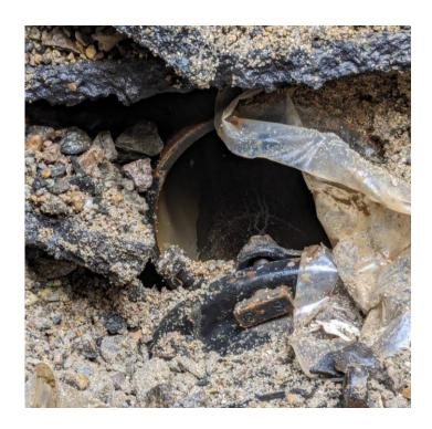
漏水を発見しました。Φ250mmの水道管が破断しています。(名古屋市)
