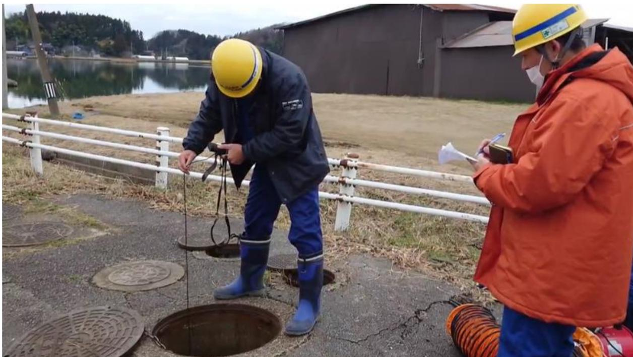
弁室に入る前に酸欠の測定をしています。
