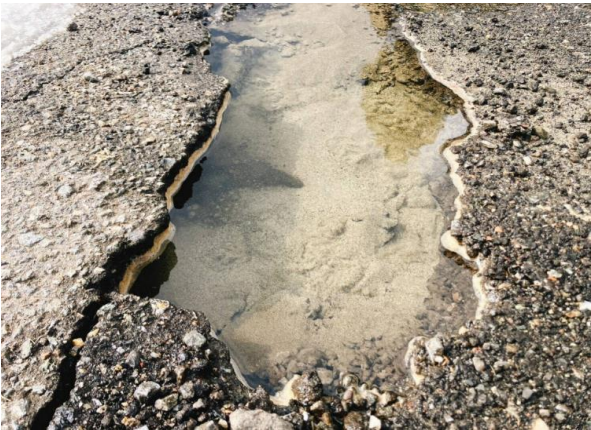
水道管の漏水状況です。
