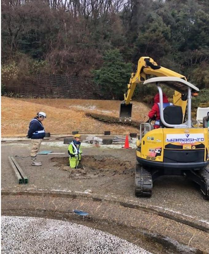
岩屋浄水場の破損した水道管を修復する工事に着手しました。
