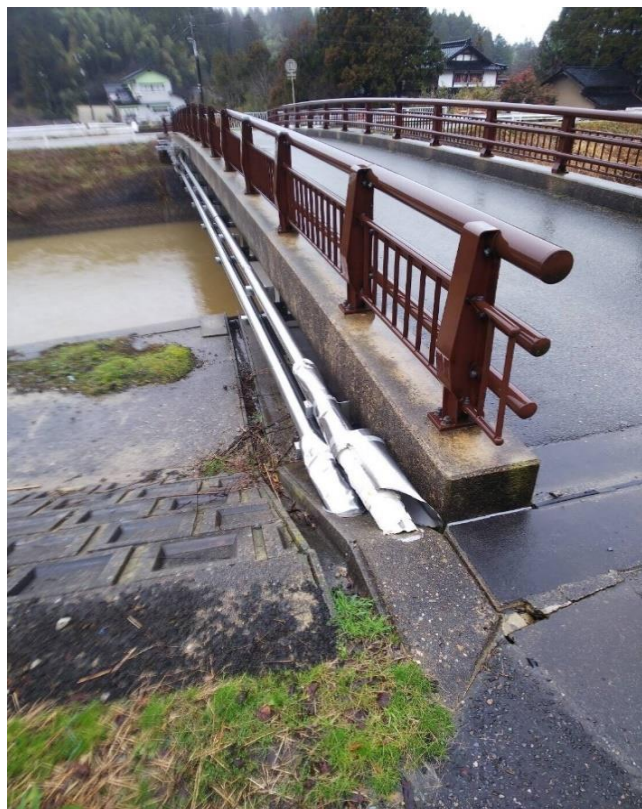
水管橋（上の管）から漏水
