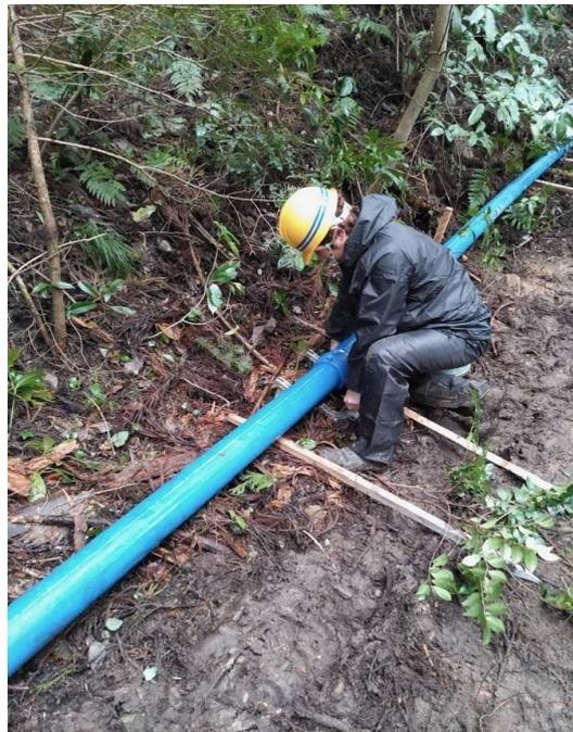
仮の管を運搬して、接合しています。
