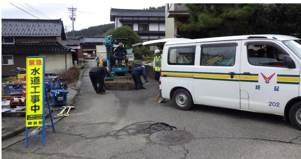
能登島曲町にて路面を掘削し、詳細な漏水箇所を確認しました。
