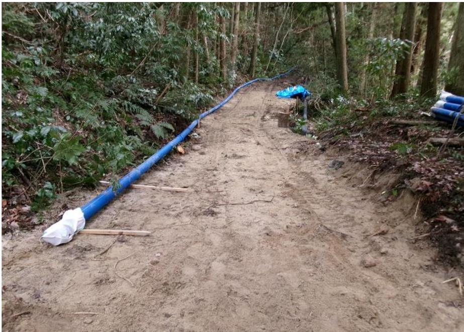
原水から岩屋浄水場までの間に仮の管を布設しています。
