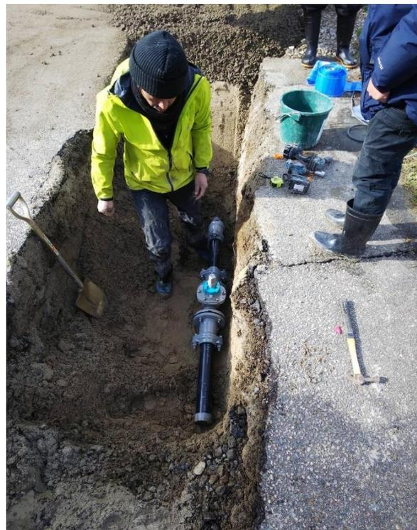
・能登島向田町地内修繕工事（仕切弁設置）の様子
