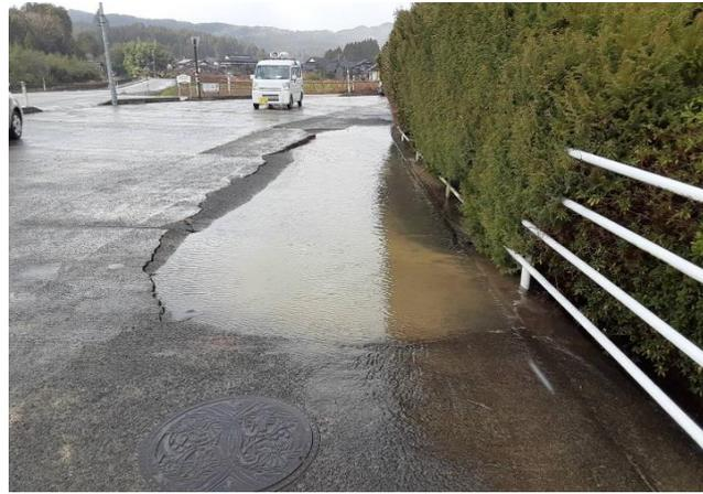
・河内配水池から藤瀬まで水を送る作業を行ったところ、中島町藤瀬地内で漏水があったため、水を送る作業を中断しました。明日以降、修繕工事を実施し、工事完了後、水を送る作業を再開し、漏水調査を行っていきます。
