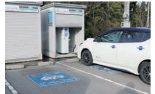
道の駅のとじまのEV充電設備
