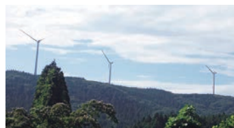
既設の風力発電機
