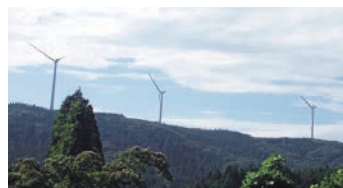
既設の風力発電機
