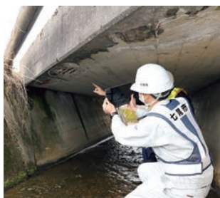
AIによる橋梁点検の様子
