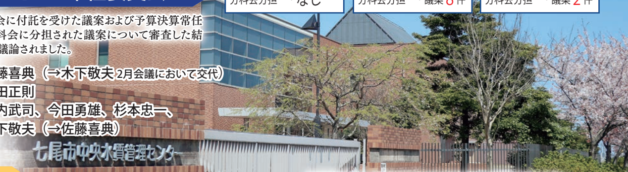
七尾地区の下水を処理する七尾市中央水質管理センター
