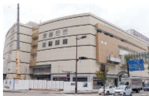
外壁工事が進むパトリア
