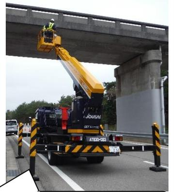
高所作業車や橋梁点検車を活用し近接目視点検を行い、正確な損傷の把握に努めています。
