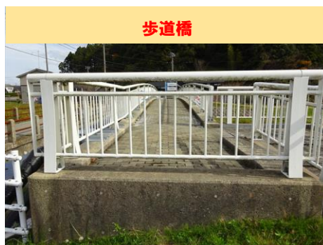
歩道橋（新屋橋歩道橋）
