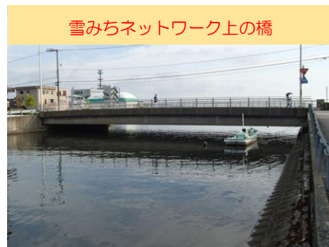
グループAの例 (桜川大橋)
