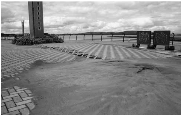
液状化現象で吹き出した砂が一面に広がったマリパーク
