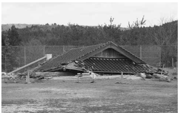
4本柱が外れ、屋根が落ちた中島小学校相撲場
