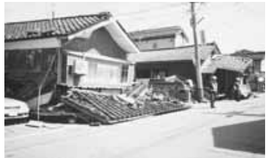
長屋風に奥に増改築した古い木造住宅といった、不整形の家に被害が集中。全壊家屋周辺の新しい木造住宅などは、ほとんど被害が見られなかった。
