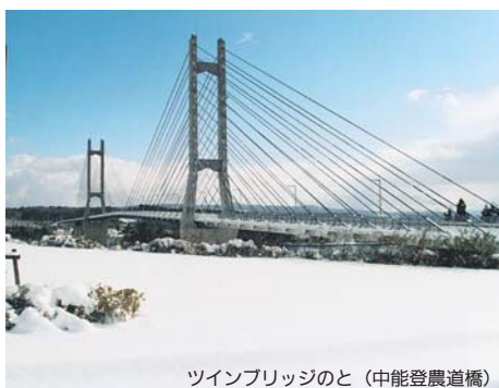
ツインブリッジのと(中能登農道橋)
